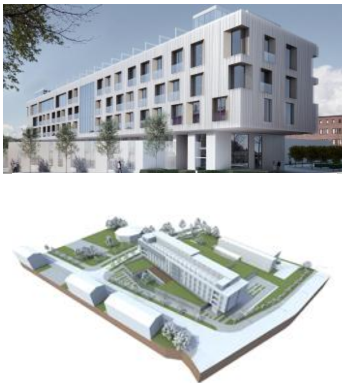
Figur 2: Skandionkliniken. Den övre bilden visar Skandionkliniken från gatuplan. Endast det nedre planet är kliniken, den övre delen är hotell. Entrén till kliniken är på motsatt gavel till den som visas här och utrustningen står i högra hörnet på gaveln mot betraktaren. Det som syns ovan mark är däremot fyra meter tjockt bjälklag i betong. Den nedre bilden visar Skandionkliniken och dess inplacering i omgivningen. Källa övre bilden: www.akademiskahus.se . Källa nedre bilden: www.skandionkliniken.se .
